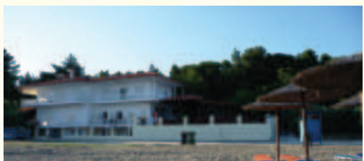
KUĆA ALEXANDRA GPS N 40.259388/E 23.490658
