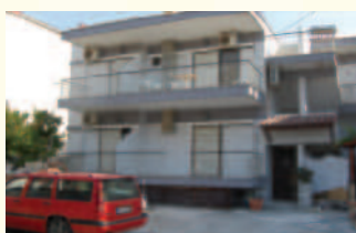
5. KUĆA NEFELI GPS N40.095856/E23.776558
